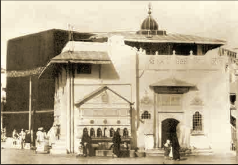
Zemzem kuyusu üzerine Osmanlılar tarafından yaptırılan Zemzem binası ve bu yapının arka cephesinde I. Abdülhamid'in yaptırdığı çeşme ve musluklar
